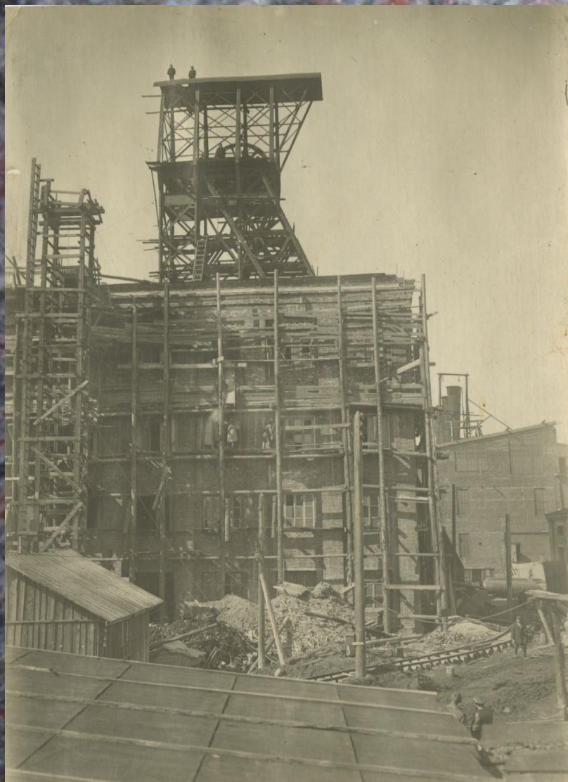
Копия. 1930 год. Строительство копра над крышей горного цеха калийного комбината.
